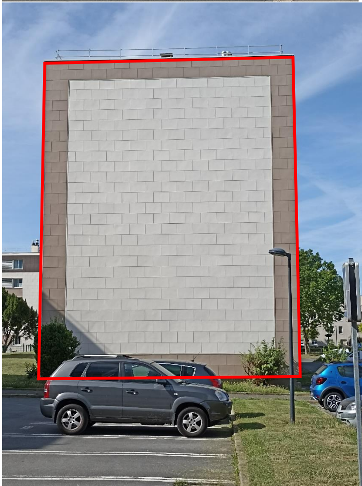
Paroi composée d'éléments de bardage en plaques Schéma et dimensions :
