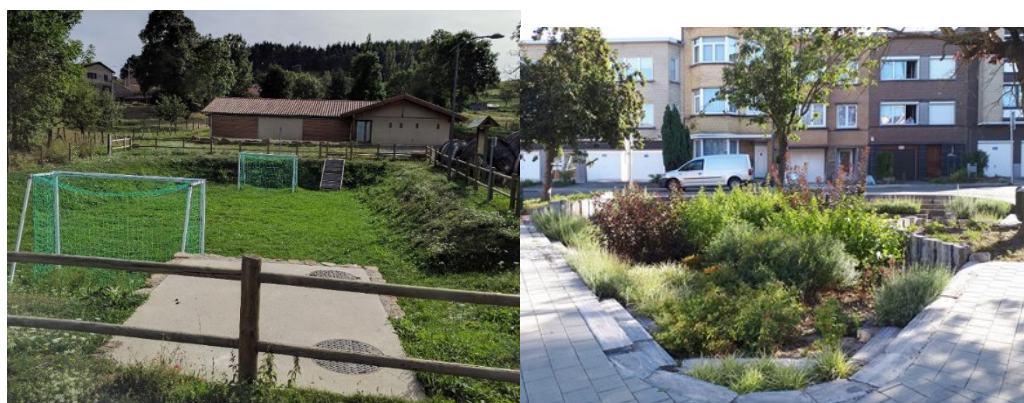
Ouvrage de stockage des eaux pluviales par temps de pluie et aire de jeux par temps sec - Chazelles-sur-Lavieu (42) source Graie / Jardin de pluie à Bruxelles source guide bâtiment durable - Bruxelles Environnement
