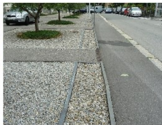
Photo 7 : Tranchée drainante (Copyright : CETE de l'Est – A. Gerolin)
