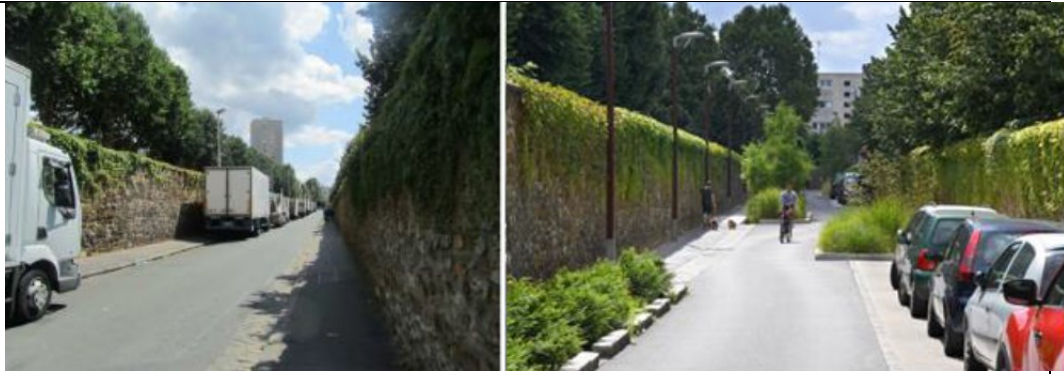
Rue Sœur Valérie à Asnières-Sur-Seine Source : ATM
