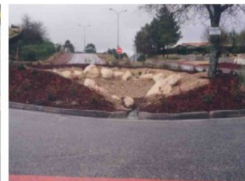
Photo 8 : Puits d'infiltration (Copyright : Siba)
